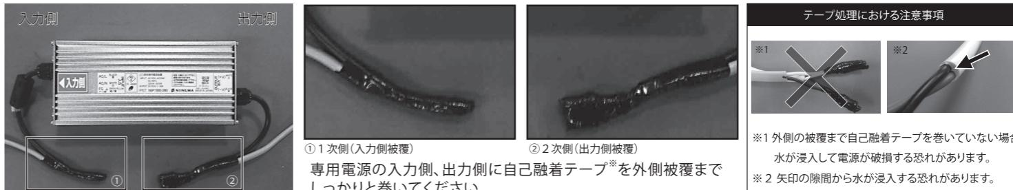
※自己融着テープ(例:エコテープ等)電線、水道、ガス、システム配管などの屋外用テープとして使用します。
