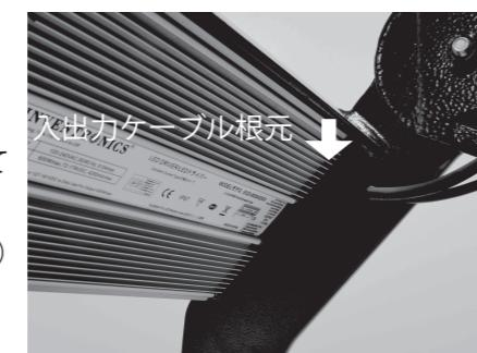
②専用電源の入出力ケーブルの根元に雨水がつたっていかない様根元より下げてご使用してください。
